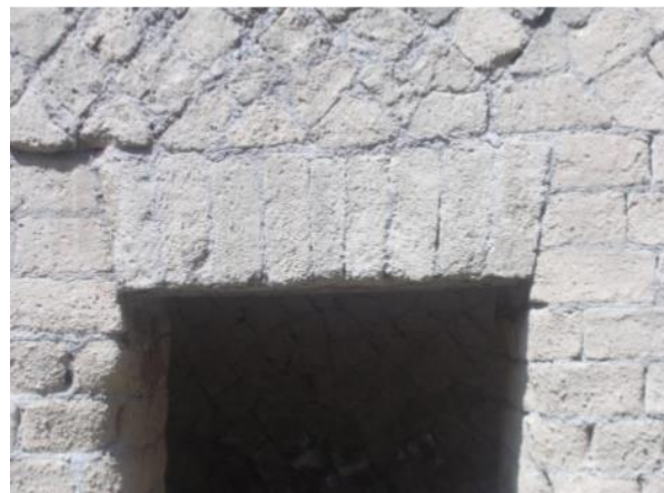
Fig. 13. c-d) due tipologie di piattabande in tufo
