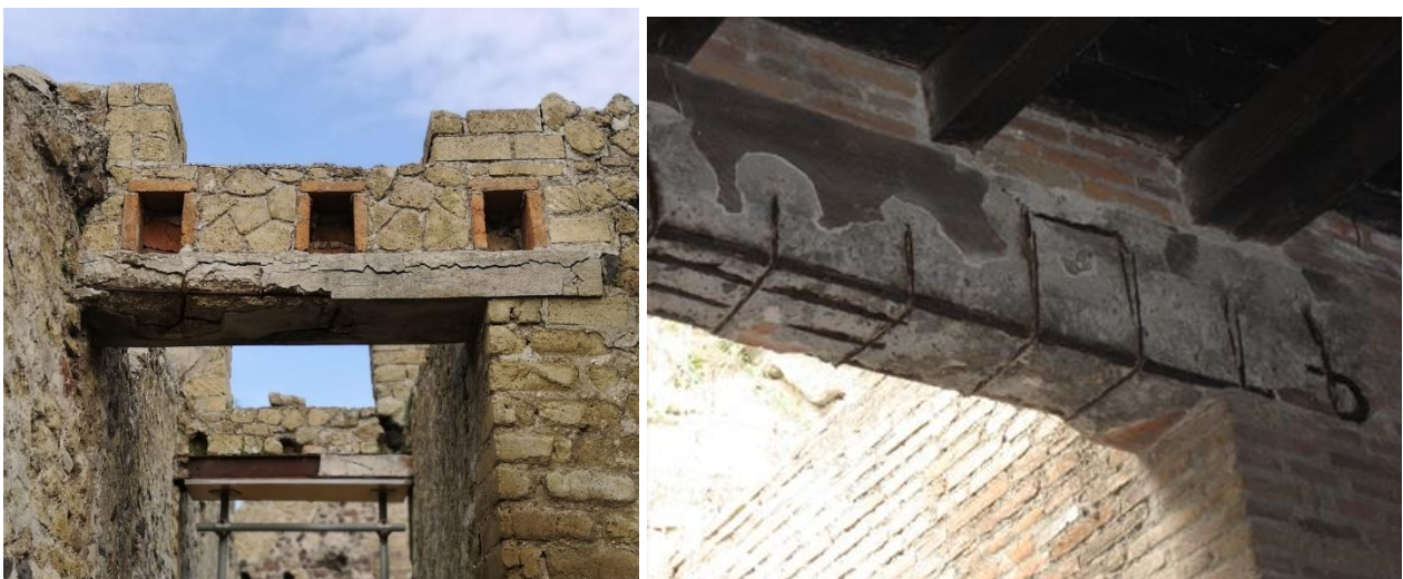
c) d) Fig. 11. c-d) esemplari di architravi in cemento armato degradati
