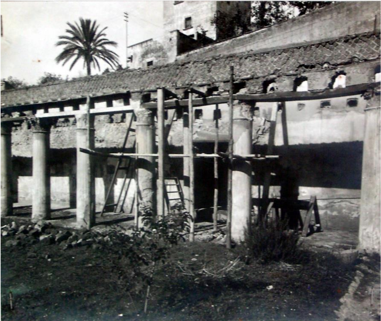
Fig. 5. Il lato ovest del peristilio della Casa d'Argo in fase di restauro 1925 con il rifacimento di porzioni di architrave in sostituzione di quelli in legno.
