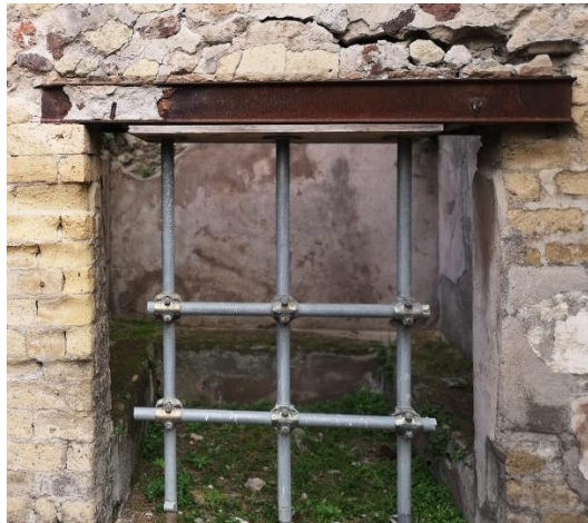
Fig. 7. c) architrave con putrelle e tracce del rivestimento in intonaco d) architrave con putrelle del Novecento ossidato e privo di rivestimento
