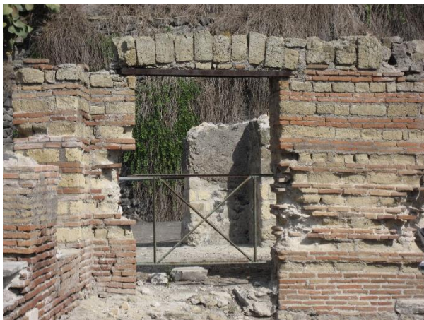
Fig. 13. c-d) due tipologie di piattabande in tufo
