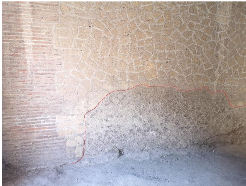
Fig. 3. La parete interna di un altro edificio: si può distinguere chiaramente in basso un lacerto di muratura originaria in opera reticolata, inglobato all'interno di una parete di integrazione in opera incerta.
