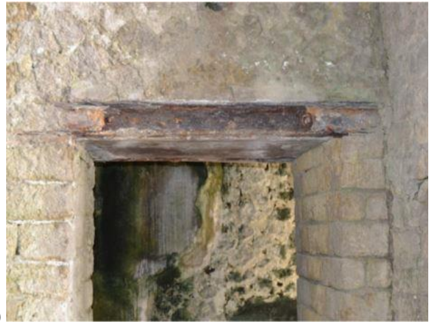
Fig. 7. c) architrave con putrelle e tracce del rivestimento in intonaco d) architrave con putrelle del Novecento ossidato e privo di rivestimento
