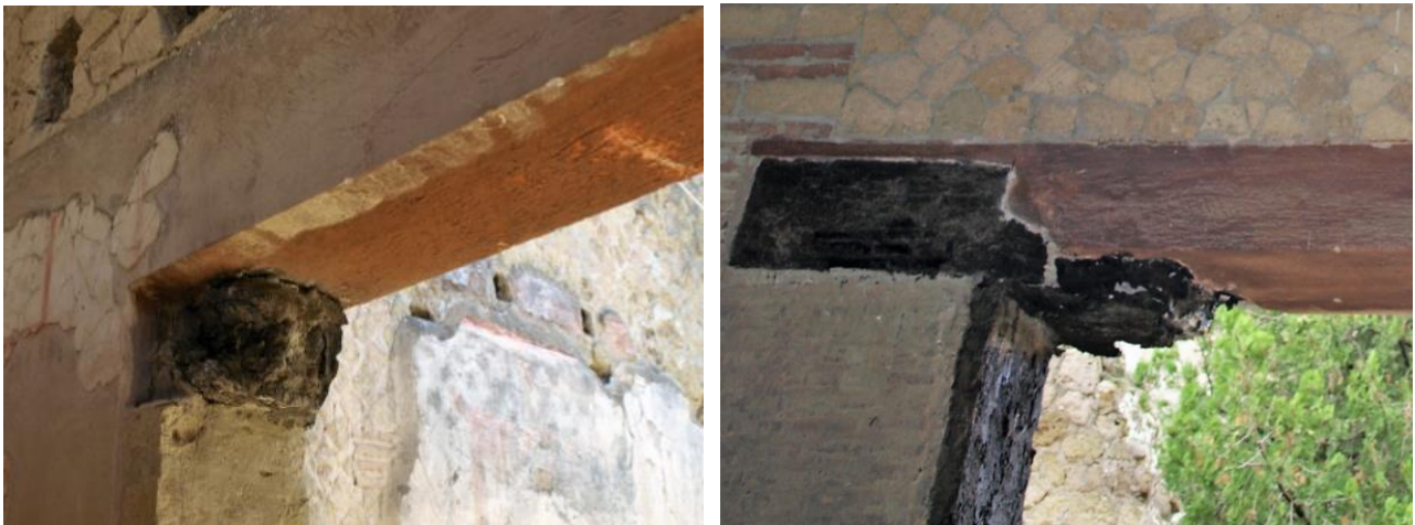
a) b) Fig. 10. a) residui carbonizzati di antichi architravi lasciati alla quota originale su cui imposta l'architrave moderno in cemento armato; b) integrazione architrave e stipite in legno carbonizzato antichi e architrave moderno in cemento armato
