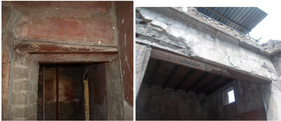
a) b) Fig. 9. a) architrave in putrelle con affresco fatto riaderire al di sopra; b) architrave in putrelle con intonaco dipinto fatto riaderire al di sopra
