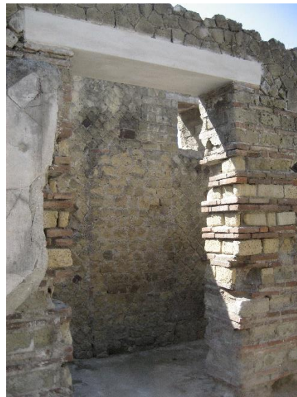
Fig. 12. a-b) intervento di manutenzione su di un architrave in cemento armato
