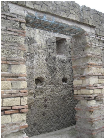
Fig. 12. a-b) intervento di manutenzione su di un architrave in cemento armato
