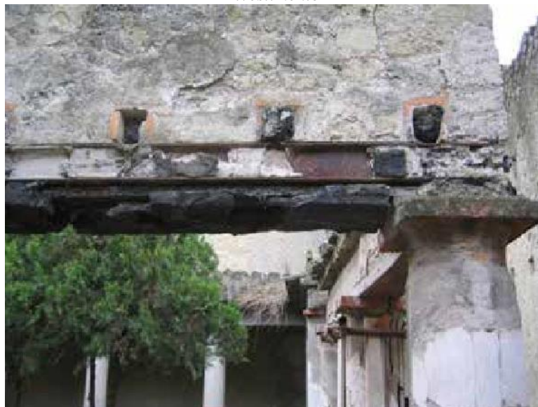
Fig. 8. Architrave in putrelle con resti della trave carbonizzata all'interno impiegati per camuffare l'intervento moderno
