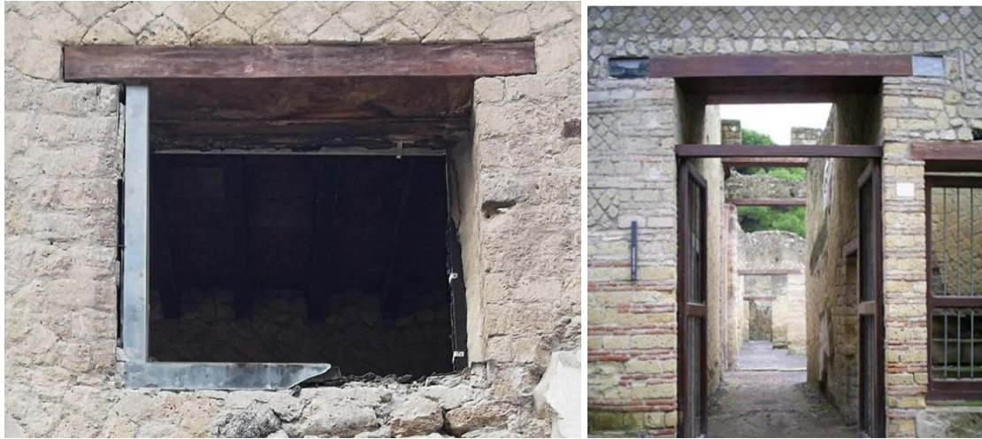
Fig. 6. a)-b) architravi in legno a massello impiegati ad integrazione di porzioni di architravi e stipiti in legno carbonizzato lasciati in situ.
