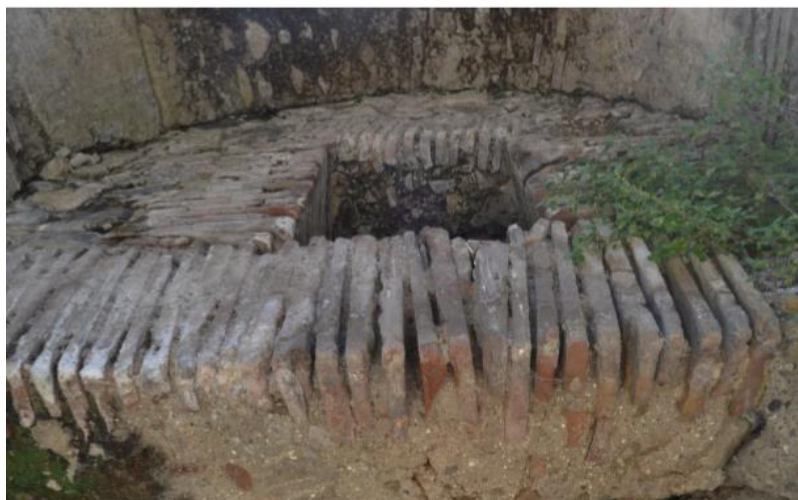
Fig. 14. Piattabanda in laterizio
