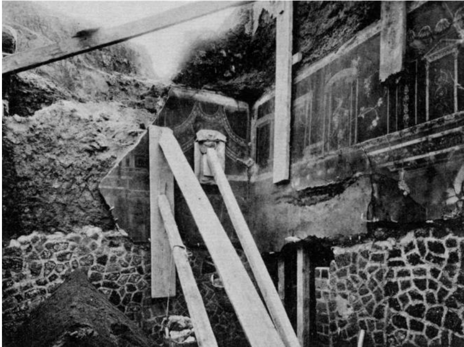
Fig. 2. Una parete dipinta assicurata in basso da muri di restauro appena realizzati apparecchiati con la tecnica ad incerto (da Maiuri 1958).
